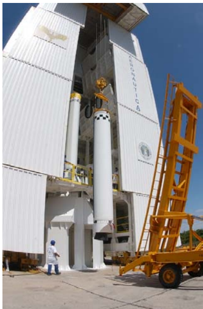
Figura 24 - Içamento para integração do primeiro estágio.
