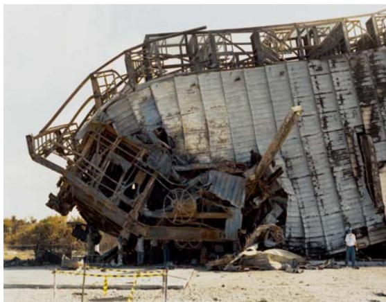
Figura 58 - Vista lateral da torre móvel de integração, lado dos propulsores A e B.
