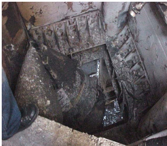
Figura 51 - Vista superior da parte central da mesa de lançamento. O vão central ficava exatamente em baixo do propulsor do segundo estágio. À esquerda, no vão, é possível observar o que restou do propulsor.
